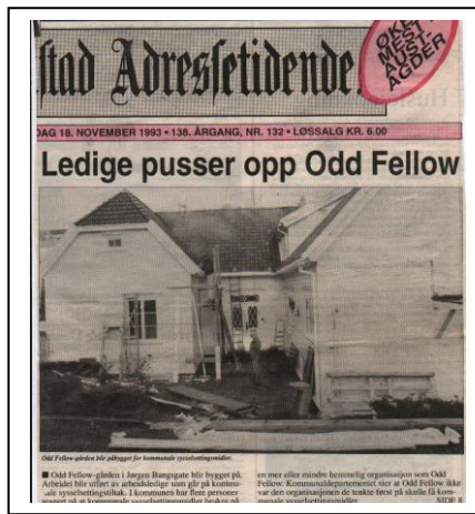
Tilbygg på Logehuset er nesten ferdig. Datert 18. November 11903
