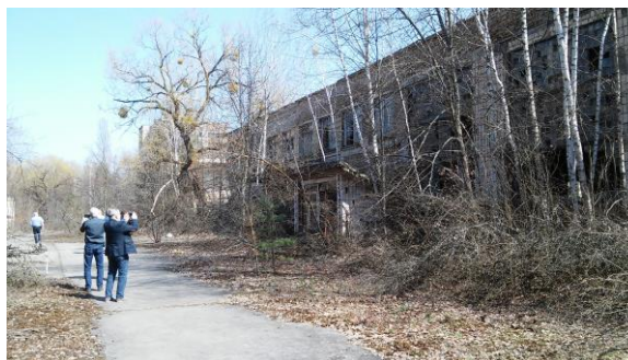
Tidligere staselige bygninger i ferd med å «forsvinne» i skogen
