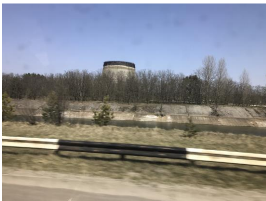
Bygging av nye kjøletårn var igangsatt
